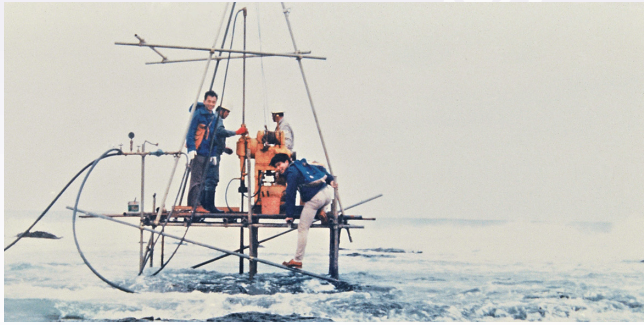
写真1：1985年3月、久米島西銘崎での離水サンゴ礁ボーリング調査の一場面。左端が高橋達郎先生、右端が菅。
